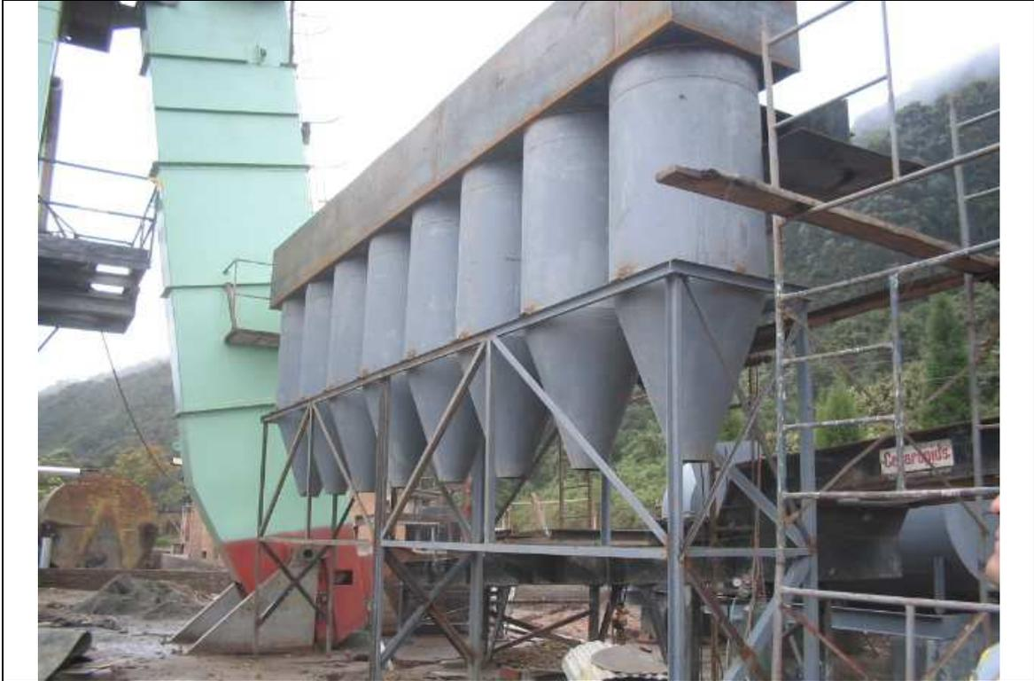
**DESCRIPCION:** Batería nueva de ocho (8) ciclones en proceso de instalación.
