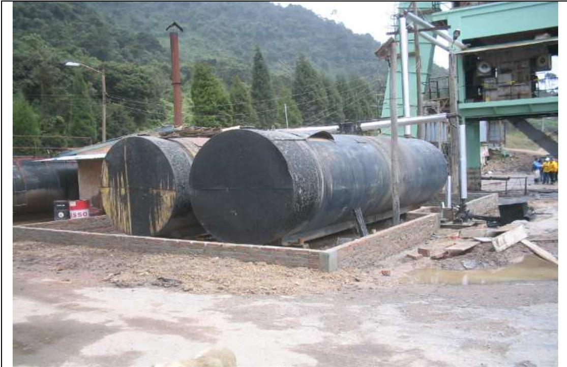
**DESCRIPCION:** Tanques de asfalto con el dique de contención.
